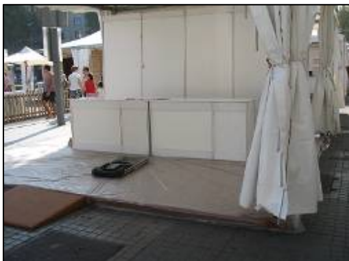
Muntatge d'un estand, on s'observa la moqueta i el plàstic que la cobreix.
