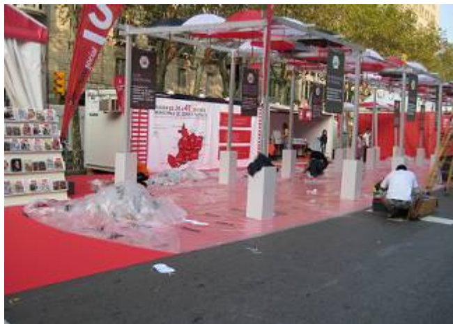
Muntatge d'un estand, on s'observa la moqueta i el plàstic que la cobreix.
