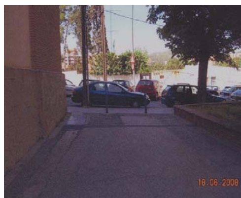
A la via Favència entre el c/Chafarines i el c/Palamós, existeix un gual i els fitons mòbils, però manca senyalitzar-ho.
