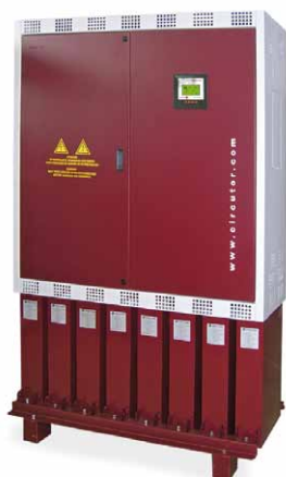
Figura 4.19: Exemple de bateria de condensadors
