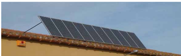
Figura 5.2: Fotografia panells solars fotovoltaïcs en instal·lació sobre coberta
