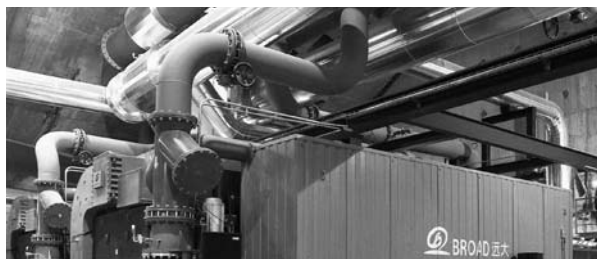
Energia de districte. Aprofitament de la calor residual de la planta de reconversió energètica de residus urbans per a alimentar la xarxa subterrània de calor i fred a les zones del Fòrum de les Cultures i 22@, Barcelona.
