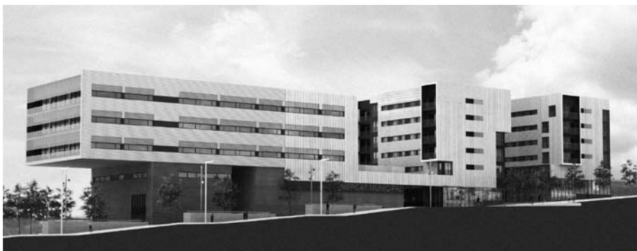
Cogeneració amb microturbina a gas i fred per absorció. Edifici Vullpalleres Centre, Sant Cugat del Vallès.
