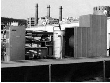
Refrigeració solar Laboratoris de l'Agència de Salut Pública, Barcelona. Vista de la màquina d'absorció, acumulació de fred, torre de refrigeració i la primera fila de captadors solars. Font: www.aiguasol.com .
