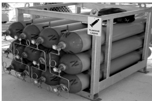
Figura 6.3. Ampolles d'emmagatzematge de GNC. Font: Plataforma LIVE.
